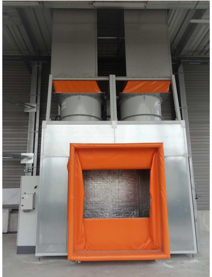
▲ Aspirateur central qui provoque un important courant d'air aux deux extrémités de la rame afin de chasser les débris et la poussière intérieure. Le cadre orange vient se coller aux doubles portes extrêmes de la rame.
